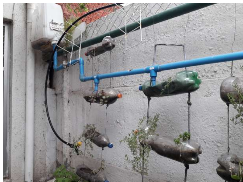
Riego de huertas verticales con captación de aguas lluvias
