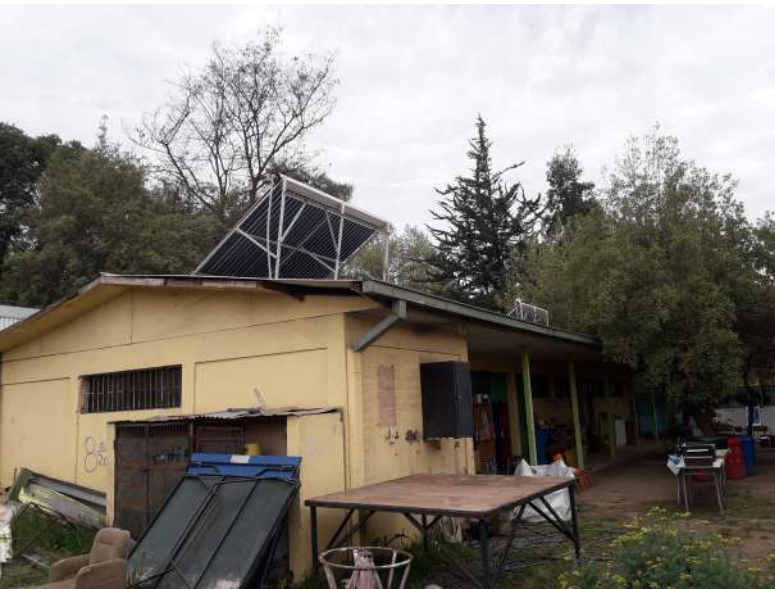
Paneles Termo-solares para duchas
