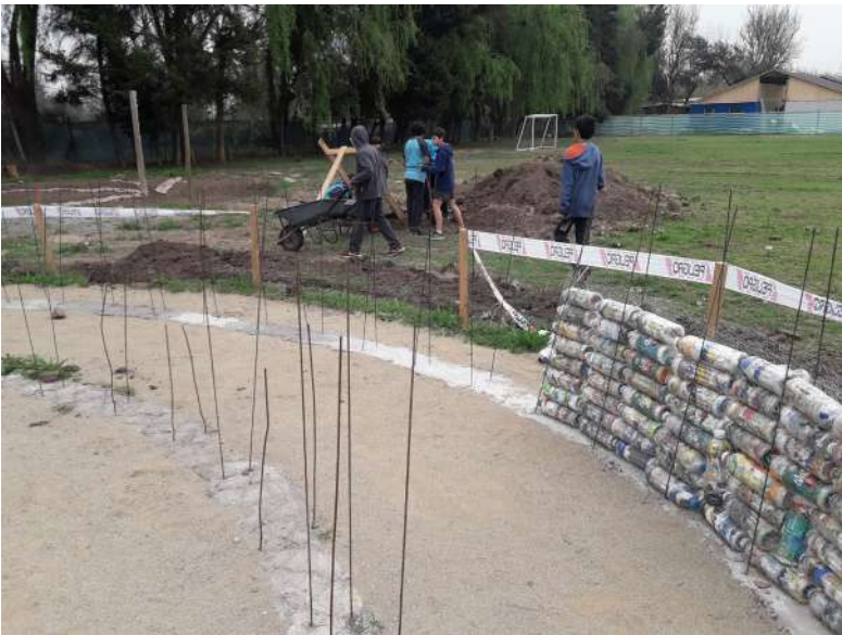
Construcción de sala laberinto con eco-ladrillos
