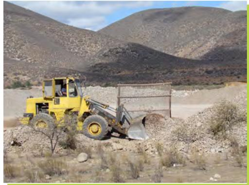
**Figura 25:** La extracción de áridos en el estero Auco además de degradar el paisaje, tiene efectos negativos en su capa freática.
