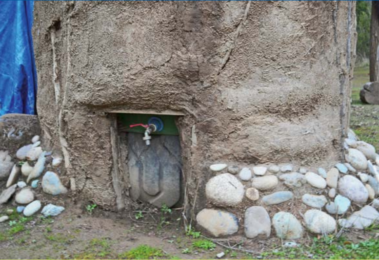
Estanque plástico de 2500 litros en San Fabián. Nótese que, para ganar altura (presión), se ha montado el estanque sobre un neumático de tractor, relleno de piedra y tierra. Además se ha recubierto el estanque con barro, para prevenir el daño del estanque por rayos UV y además mantener más fresca el agua.
