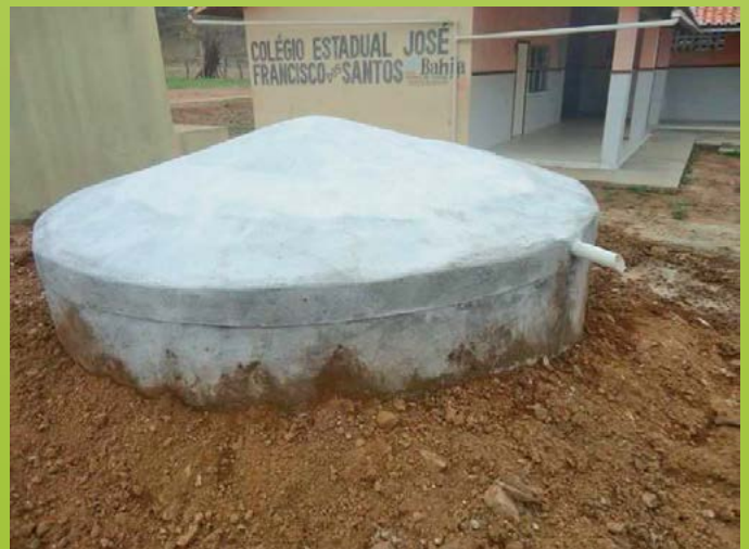
Estanque de ferrocemento semienterrado, Brasil.
