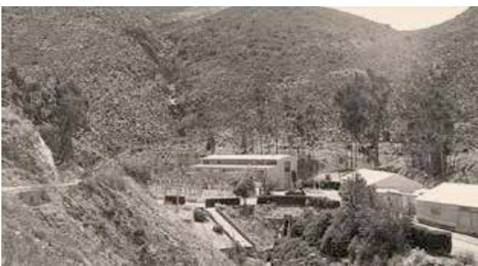
▲ Canal de Azapa y Central Chapiquiña. El agua proveniente desde el río Lauca cumple doble función: ayudar en la generación de electricidad y regar los cultivos del valle de Azapa.
