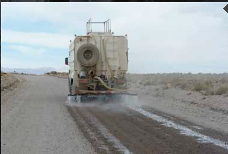
Uso de agua extraída de la vega de Misitune para control de material particulado en camino a Salar de Surire (GLO).
