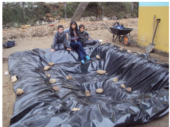
Instalación polietileno
