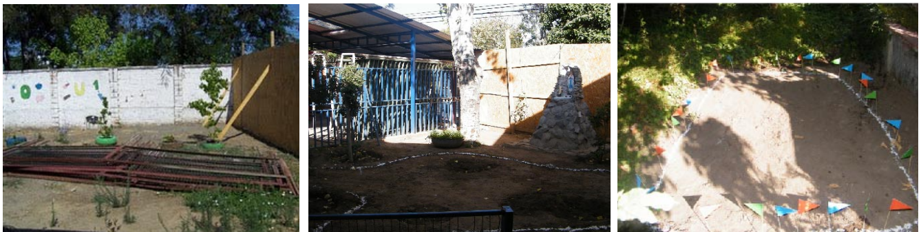
Lugares antes de la construcción
